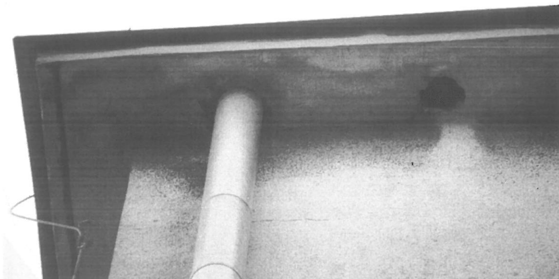
Fot. 5. Kraków, Na Kozłowie 29 – ściana południowo-wschodnia budynku. Otwór po rurze spustowej. Konieczne zamknięcie do końca lutego, by uniemożliwić zagnieżdżenie się ptaków.
