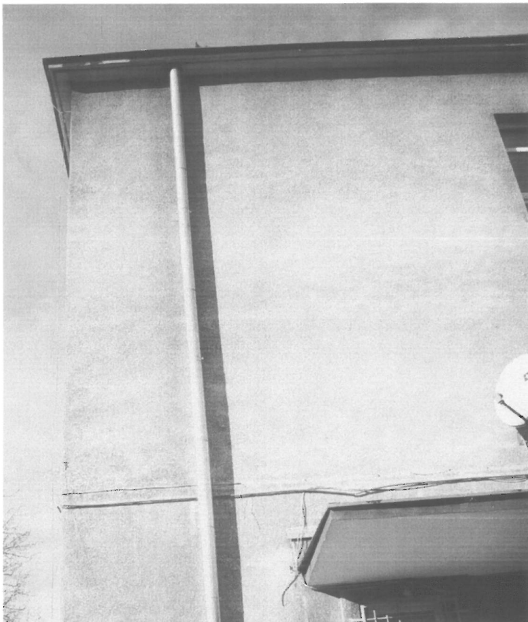
Fot. 6. Kraków, Na Kozłowie 29 – ściana północno-zachodnia budynku.. Szczeliny przy wejściu rury spustowej przez okap. Konieczne zamknięcie do końca lutego, by uniemożliwić zagnieżdżenie się ptaków.
